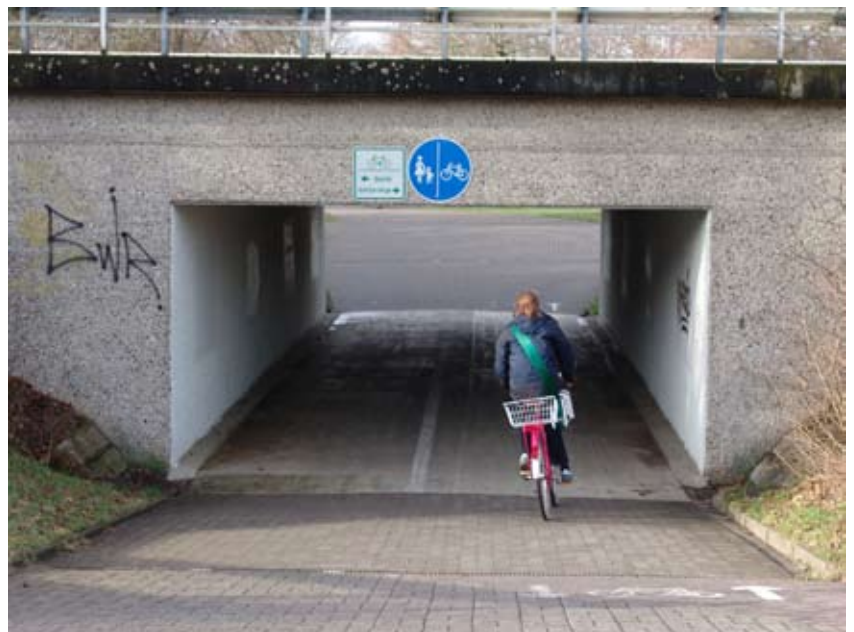
Unter der Bundesstraße 443 können Radler nicht sehen, ob ihnen auf der anderen Seite des Tunnels von links oder rechts jemand entgegenkommt: Der Radweg mündet dort in scharfe 90-Grad-Kurven.
