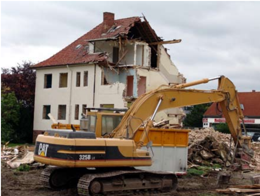
Für einen dritten Lebensmittelmarkt in der oberen Marktstraße musste der große Bagger ein altes Burgdorfer Mehrfamilienhaus abreißen.
