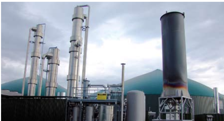
Energiepolitik droht in Burgdorf schnell in die falsche Richtung zu laufen: Nur massive Bürgerproteste konnten ein Biogaswerk der Megaklasse in Hülptingsen verhindern.
