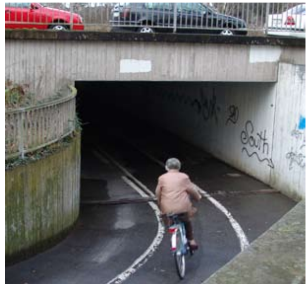
Am Finanzamttunnel müssen Radler in ein dunkles Loch fahren.
