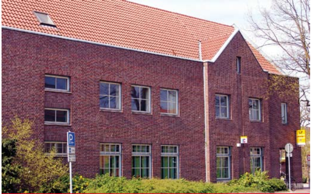
Mit Aldi und Cramer reichen den etablierten Parteien zwei Lebensmittelgeschäfte in der oberen Marktstraße noch nicht: Ein neuer Großmarkt zieht als dritter im Bunde ins Postgebäude ein. Für Bewohner der südlichen Weststadt und aus Heeßel ist dagegen die Nahversorgung gekappt, weil sich der Rat weigerte, das Angebot eines Investors ernsthaft zu prüfen.
